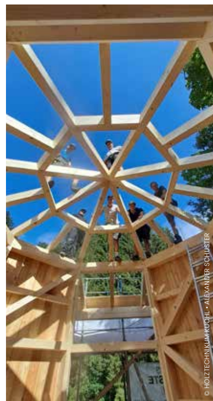
SCHÜLER DER FACHSCHULE HABEN ANLÄSSLICH IHRER ABSCHLUSSARBEIT FÜR DAS SOZIALPROJEKT BADHAUS IN LEOGANG EIN BARRIEREFREIES SPIELHAUS AUF STELZEN GEFERTIGT • AS PART OF THEIR FINAL PROJECT, STUDENTS FROM THE VOCATIONAL SCHOOL BUILT AN ACCESSIBLE STILTED PLAYHOUSE FOR THE BADHAUS SOCIAL PROJECT IN LEOGANG.
