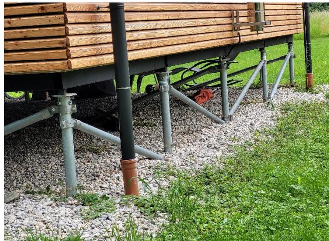
Abbildung 8: Schraubfundamente, unverbaut (links), Foto ©: www.baubiologie.at
