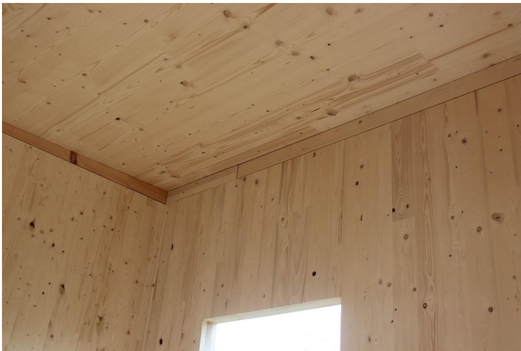
Abbildung 13: Wand- und Deckenkonstruktion aus Brettsperrholz
