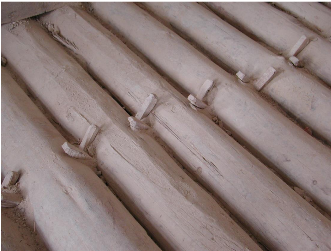
Abbildung 9: Freigelegte Doppelbaumdecke
