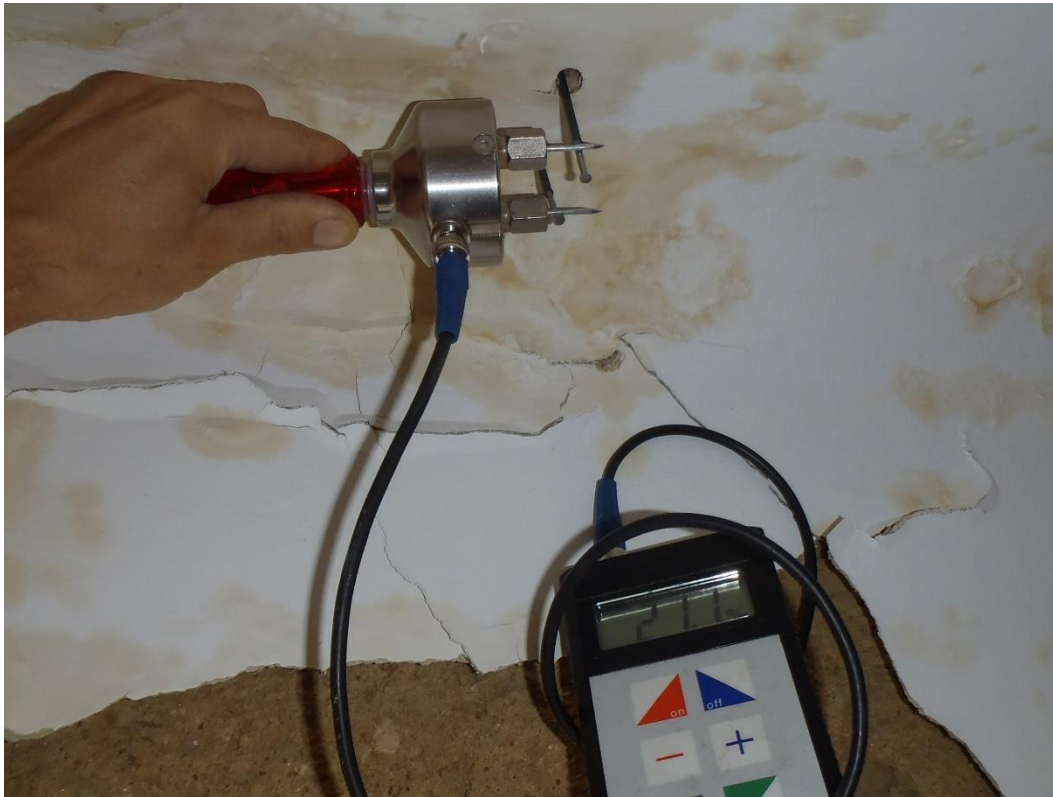
Abbildung 3: Holzfeuchtemessung mit langen Elektroden an einer durchfeuchteten Dippelbaumdecke
