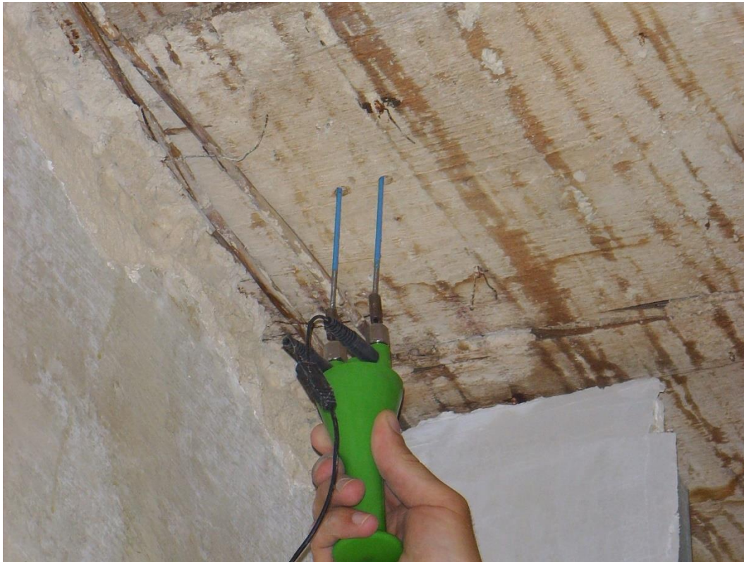
Abbildung 12: Messung der Holzfeuchtigkeit mit langen Elektroden im Inneren der Dippelbäume einer Holz-Beton-Verbunddecke
