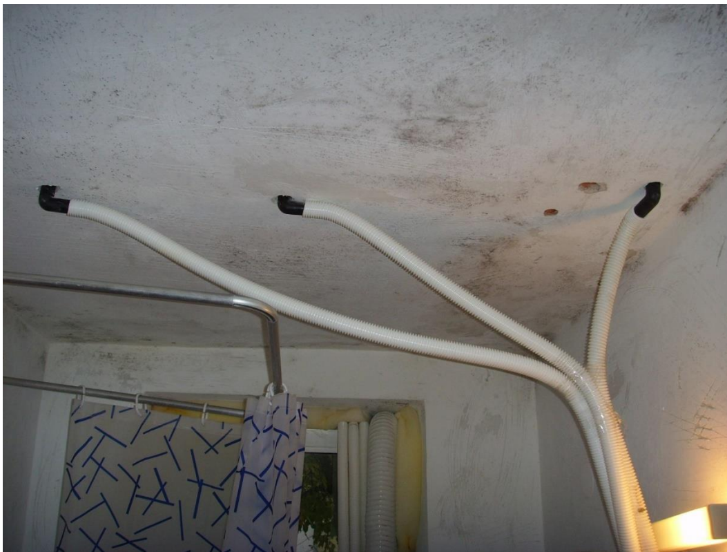
Abbildung 7: Trocknung einer durchfeuchteten Tramdeckenkonstruktion im Überdruckverfahren
