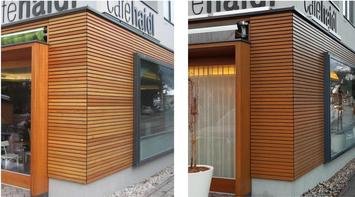
Abbildung 2: Links: Transparent beschichtete Lärchenholzfassade; Rechts: dieselbe Fassade 10 Jahre später nach Applikation eines Wartungsanstriches. Die Beschichtung ist aufgrund der Wartung nach 10 Jahren noch vollständig intakt.
